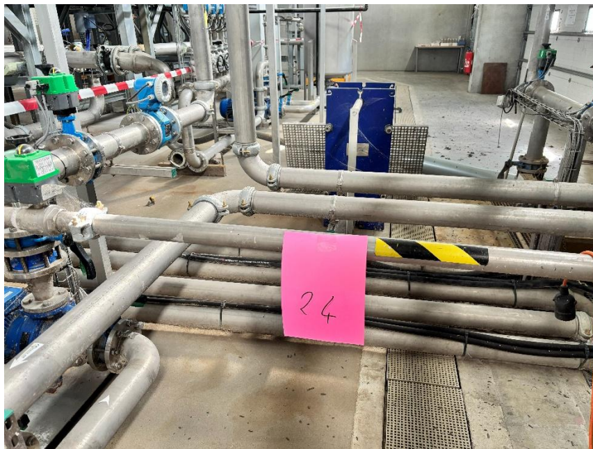
24 Un ensemble de gestion de l'eau, automatisme avec pompe, de marque MISPOUILLÉ, ensemble de tuyauterie et échangeurs qui composent cet ensemble et armoire électrique
